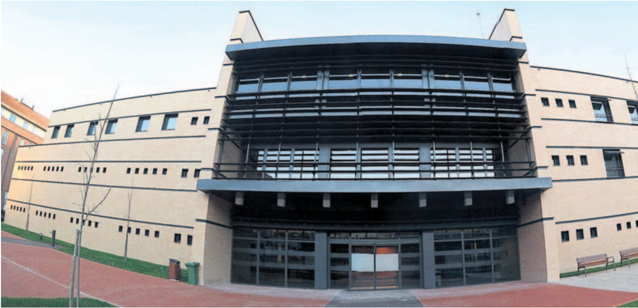
El nuevo geriátrico de Lakua se levanta en una parcela rectangular de más de 5.000 metros cuadrados ubicada en la confluencia de la calles Baiona y Zarautz. :: FOTOS: IGOR AIZPURI
