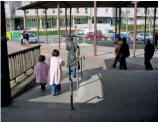
■ Accesos a la estación de autobuses.
