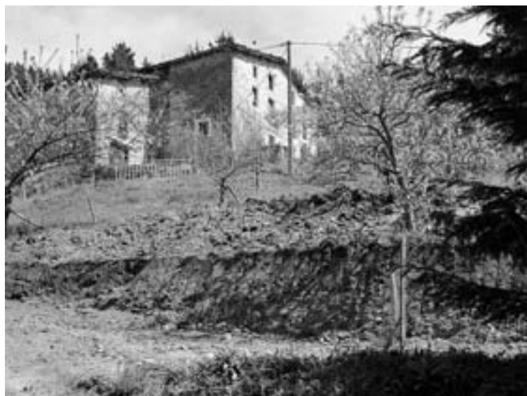
AIXOLA. Edificio que va a ser rehabilitado. / M. E.
